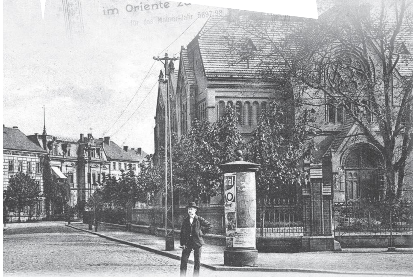
Siedziba loży masońskiej Pythagoras zu den drei Höhen im Orient przy Piastenstraße (ob. ul. Piastowska), 1908 r.
